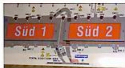
Einmalig: Bereits das Abnehmen eines Feuermelders zeigt die Anzeige in der Nachrichten-Zentrale an und löst Alarm aus.
